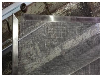
Figura 36. Colocación de las mallas para control y manejo de residuos
