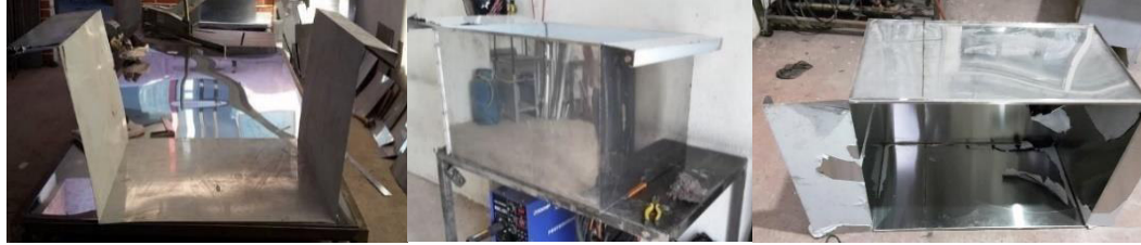
Figura 30. Construcción del tanque
