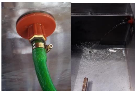
Figura 38. Instalación de boquilla de ingreso al agua
