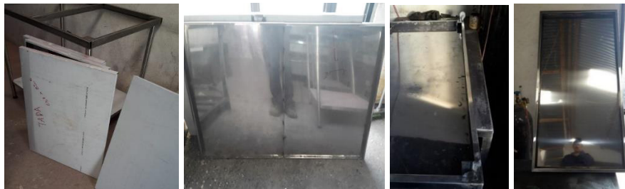
Figura 31. Construcción de recubrimiento del tanque.
