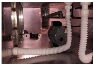
Figura 39. Instalación de tubería de drenaje
