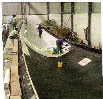
1 El casco de una embarcación se recubre con una lámina de plástico flexible antes de proceder al sellado. Más tarde se hará el vacío.
