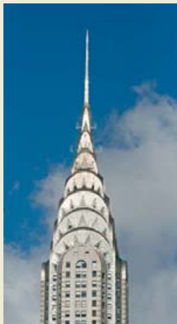
Construido en Nueva York en 1929, el pináculo de acero inoxidable del edificio Chrysler sólo se ha limpiado unas cuantas veces. A pesar del ambiente urbano, el material muestra pocos signos de corrosión.
