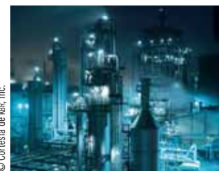
Fotografía nocturna de una gran planta industrial para fabricar amoníaco: \text{NH}_3 . En esta instalación pueden generarse al día hasta 7000 toneladas de amoníaco. Hay alrededor de 100 de estas plantas en el mundo.
