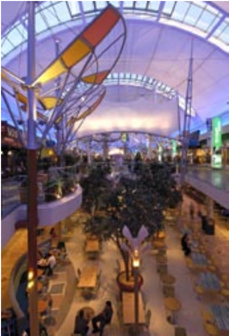
Durante el día, los atrios acristalados permiten la entrada de abundante luz natural en el edificio. Una iluminación de acento complementaria ayuda a evitar contrastes de luminosidad acusados entre la elevada luminancia del techo de cristal y los techos de las superficies de venta. Por la noche, la iluminación de las velas del techo crea una sensación espacial luminosa.
