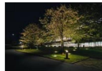
Descubrir el medio ambiente: los Uplights iluminan las copas de los árboles de una manera uniforme. Las balizas envían sin deslumbramiento su luz hacia abajo, y sirven de iluminación segura de los caminos.
