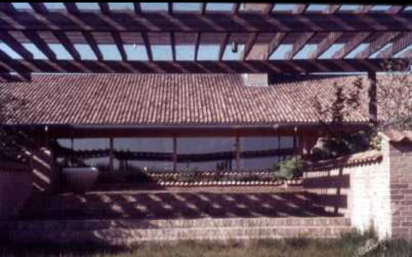
MAMPOSTERÍA DE LADRILLOS
