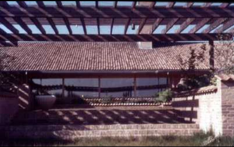
MAMPOSTERÍA DE LADRILLOS
