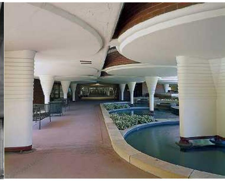
Por toda la "Gran Sala de Trabajo," una serie de delgadas columnas dendriformes se elevan para extenderse en la parte superior, formando el techo. Los espacios entre los círculos son claraboyas realizados con tubos de vidrio [Pyrex](#). En las esquinas, donde las paredes usualmente se encuentran con el techo, los tubos de vidrio continúan, y conectan con las claraboyas creando un efecto de [claristorio](#) y dejando entrar una agradable luz indirecta.
