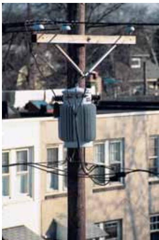
Figura 32.18 El transformador en este poste de potencia baja la tensión de CA de 4 000 V a 240 V para su distribución a residencias individuales.
