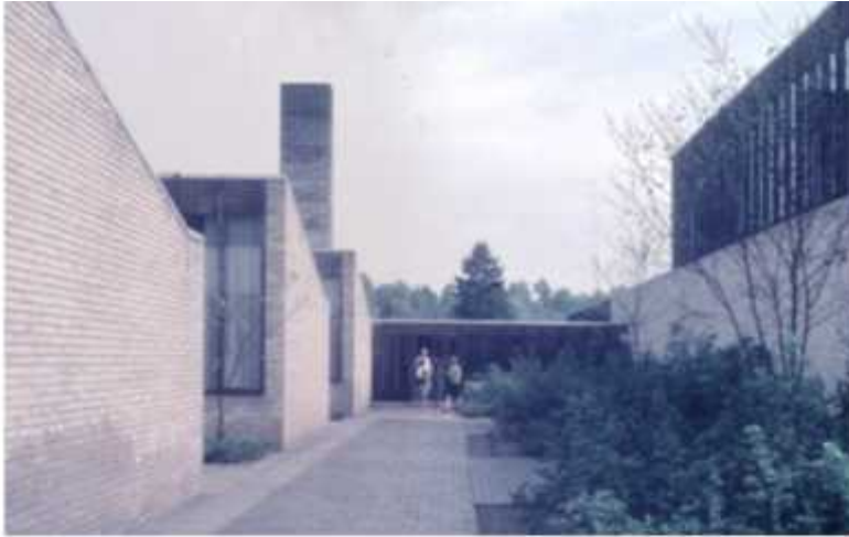
MAMPOSTERÍA DE LADRILLOS
