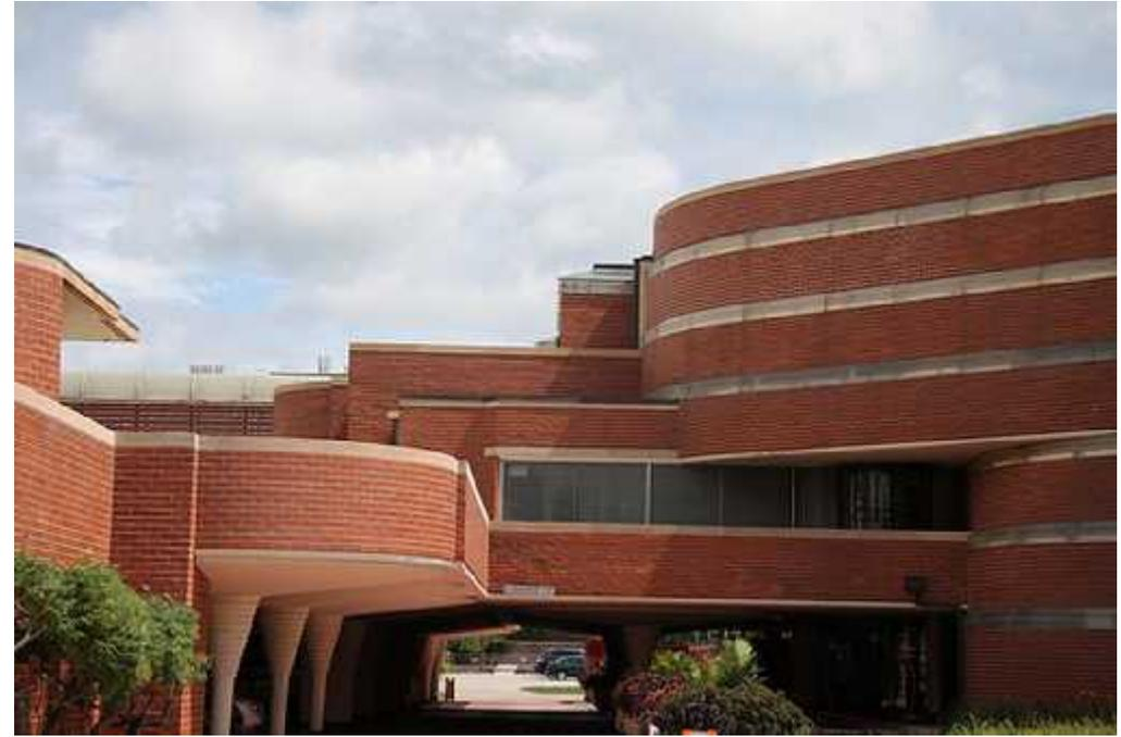
La tonalidad rojiza, cálida, de los ladrillos se usó también en la losa de hormigón pulido; las columnas dendriformes de piedra blanca crean un contraste sutil pero impactante. Todo el mobiliario, fabricado por [Steelcase](#), fue diseñado para el edificio por Wright y reflejaba muchos de los rasgos únicos del edificio.
