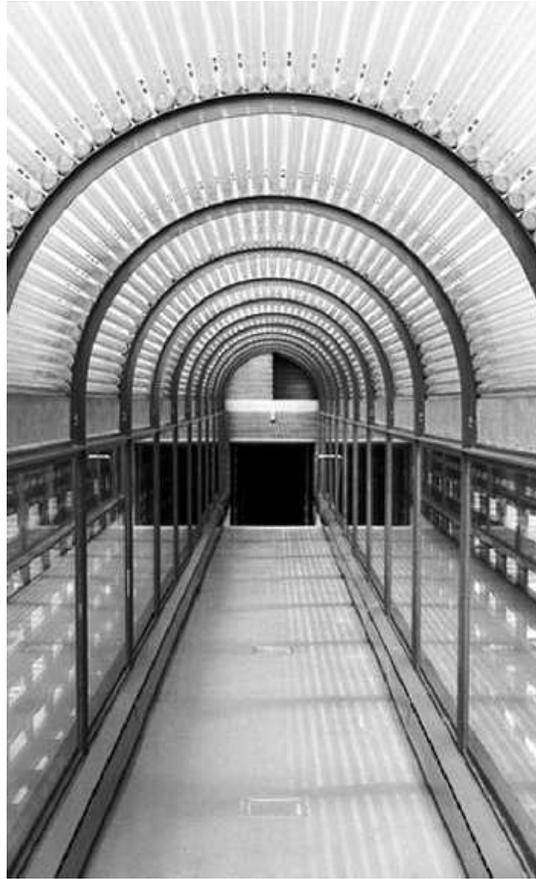
Además, era muy difícil sellar adecuadamente los tubos de vidrio de las claraboyas y el techo, causando fugas. Este problema no se solucionó hasta que la empresa sustituyó las capas superiores de tubos con claraboyas de láminas de fibra de vidrio y láminas moldeadas de Plexiglas con líneas oscuras pintadas para parecerse a las juntas originales.
