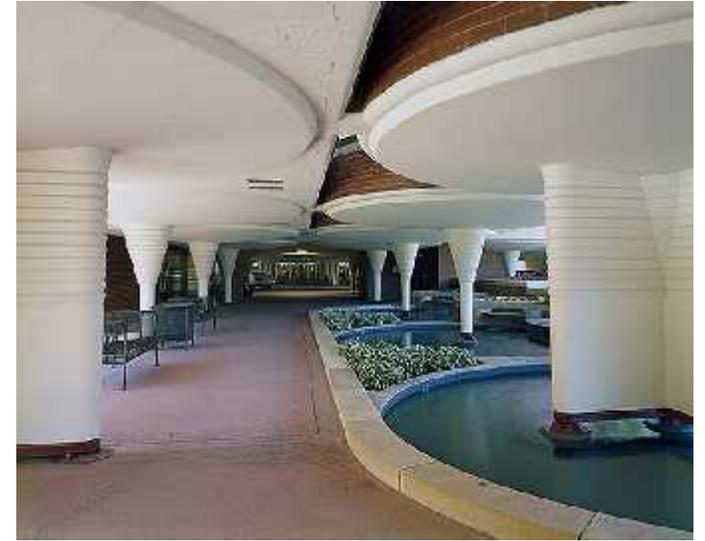
Por toda la "Gran Sala de Trabajo," una serie de delgadas columnas dendriformes se elevan para extenderse en la parte superior, formando el techo. Los espacios entre los círculos son claraboyas realizados con tubos de vidrio [Pyrex](#). En las esquinas, donde las paredes usualmente se encuentran con el techo, los tubos de vidrio continúan, y conectan con las claraboyas creando un efecto de [claristorio](#) y dejando entrar una agradable luz indirecta.
