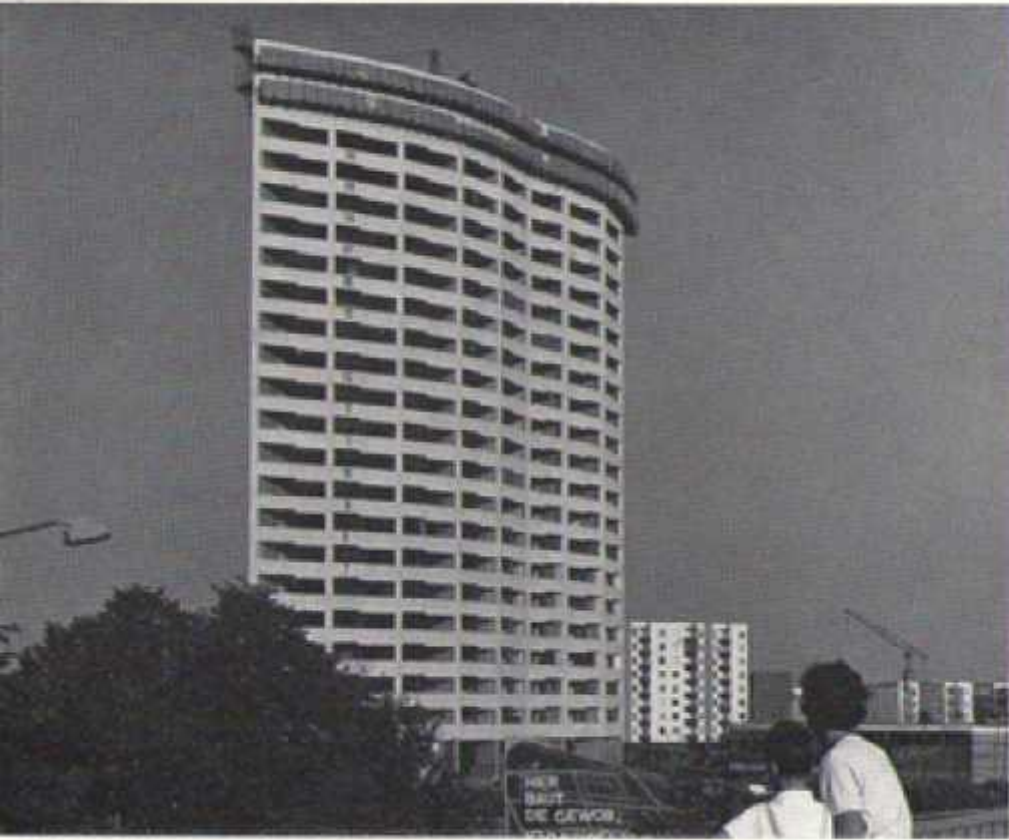
Das Hochhaus im Bau; Ostansicht L'immeuble-four en chantier; la vue de l'est The high rise building, from east
