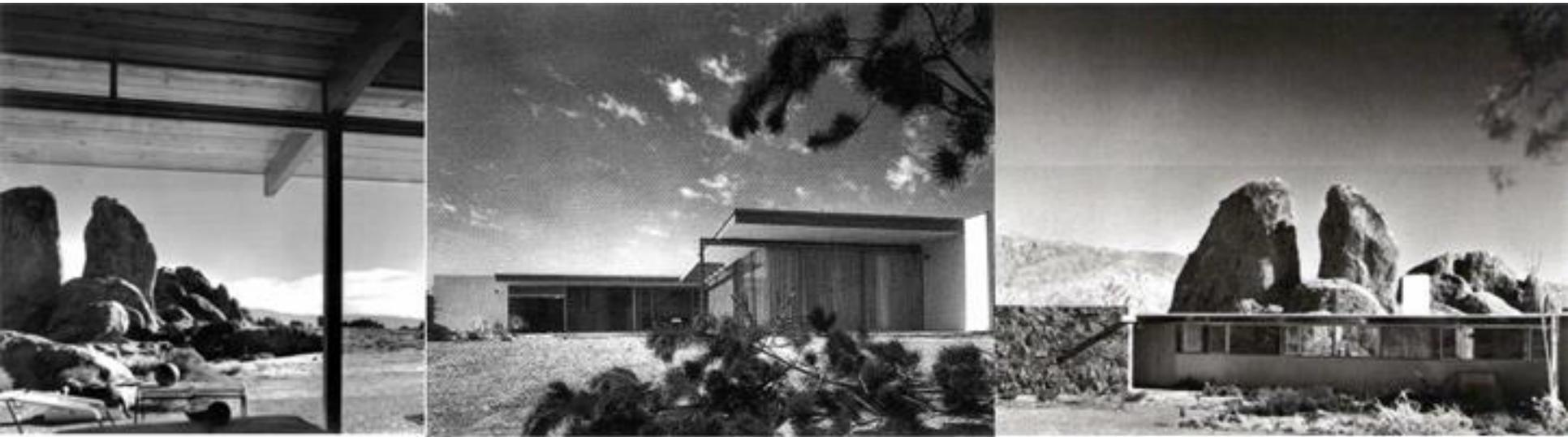
Por arriba de la altura del dintel de las aberturas, tanto fijas como de abrir, se disponen, entre las vigas de madera ventanas tipo cenital que incorporan ventilación adicional.
