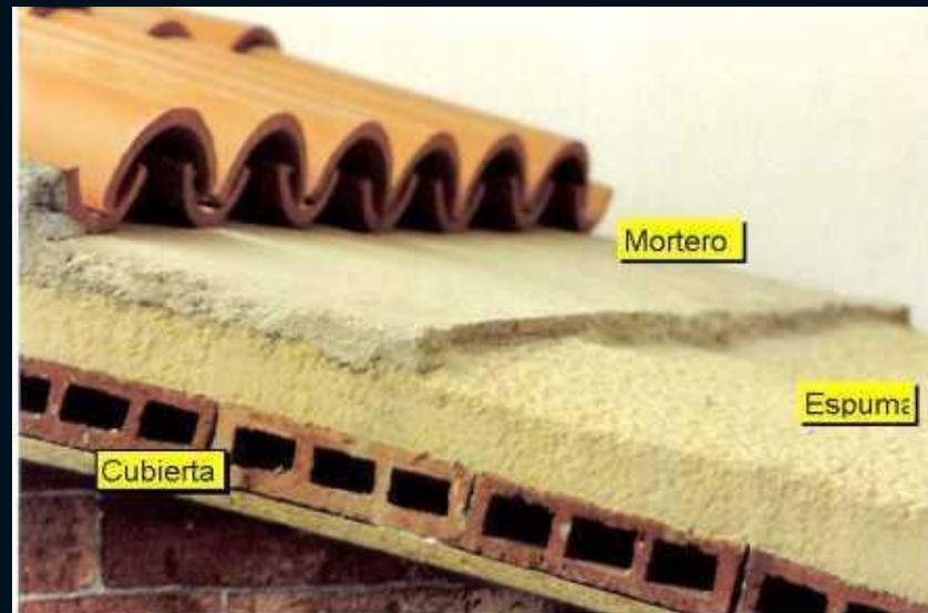
Maqueta de una cubierta aislada con poliuretano
