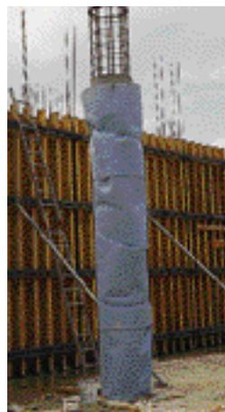
FIG. 2.5.2 Protección aislante de una pilastra.
