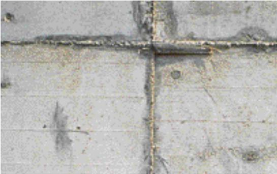
FIG. 2.6.1 Efecto de la falta de estanqueidad en el encofrado.
