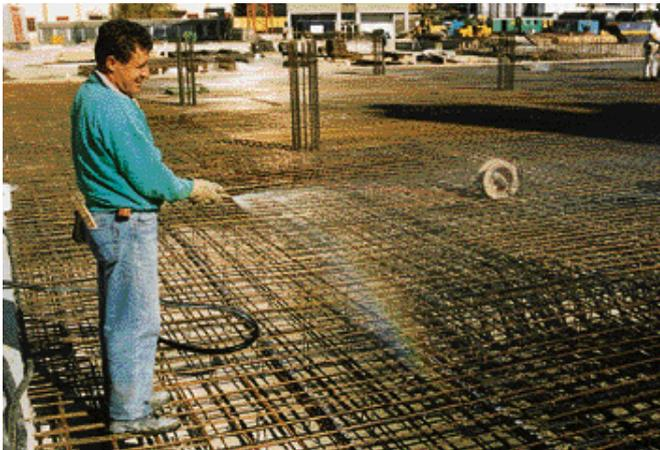
FIG. 2.7.3 Humectación del encofrado.
