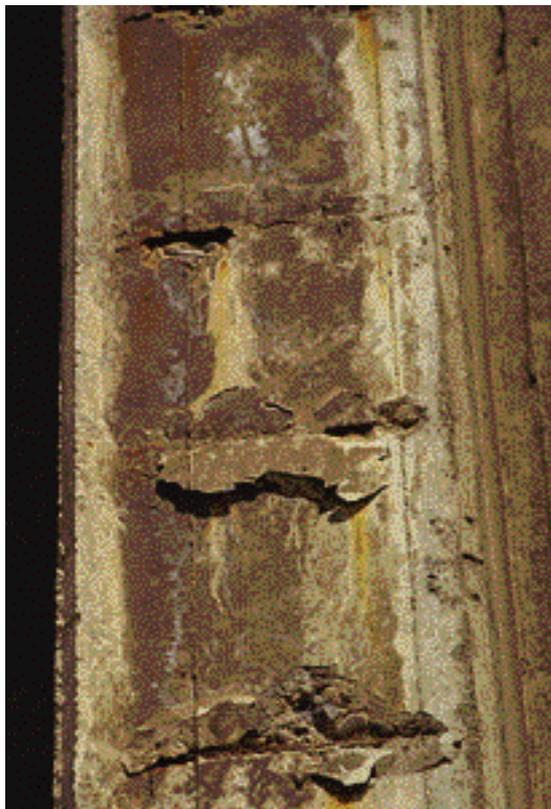
FIG. 3.3.2 El frente de carbonatación ha alcanzado la profundidad de los hierros de la armadura que han comenzado a oxidarse. A causa del óxido que se forma, su volumen aumenta y el hormigón se fisura y disgrega.
