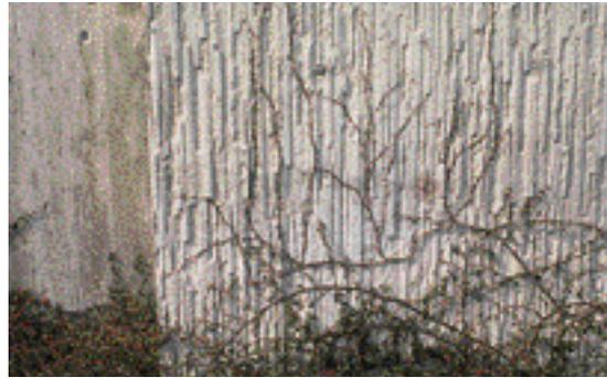
FIG. 2.6.4 Ejemplo de superficie texturada de hormigón bien lograda.
