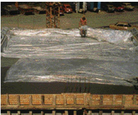
FIG. 2.5.1 Cobertura de un techo de hormigón con una lámina de plástico.
