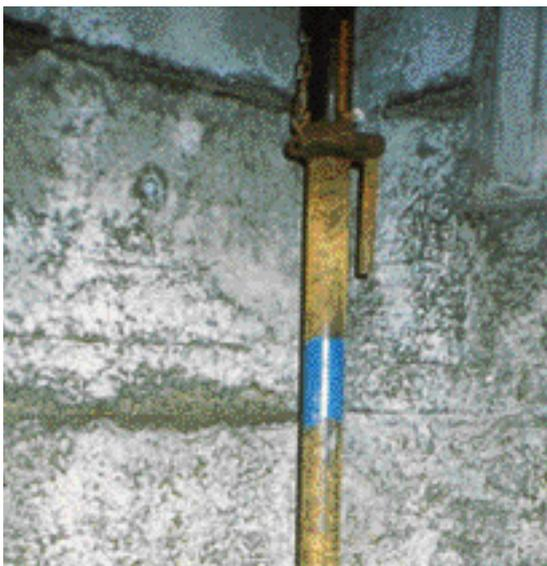
FIG. 3.1.3 Superficie poco estética resultante de la microsegregación entre los agregados finos y la pasta de cemento.
