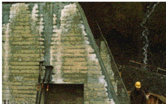
FIG. 3.4.3 Eflorescencias sobre un muro de hormigón expuesto a la lluvia, 24 horas después del desencofrado.
