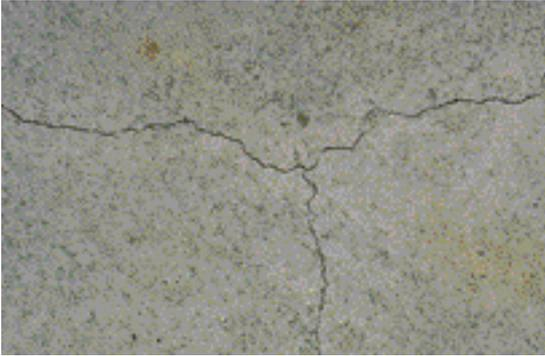
FIG. 3.2.4 Fisuras típicas de contracción en un piso de hormigón armado.
