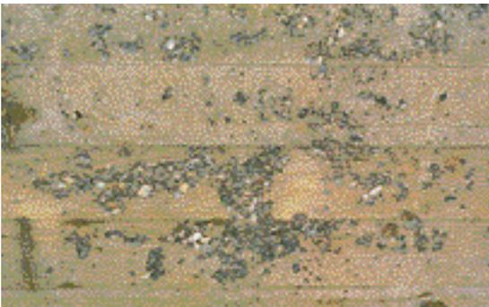
FIG. 2.6.2 Daños en el recubrimiento del hormigón.
