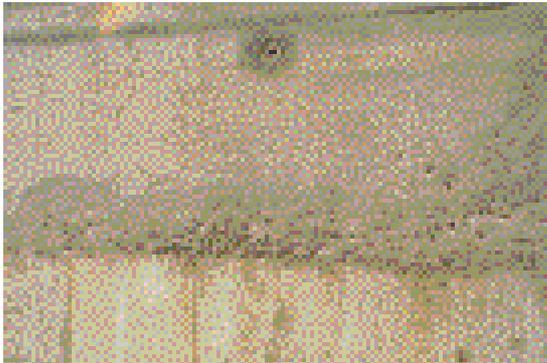
FIG. 3.1.1 Nidos de abeja formados como consecuencia de una altura de caída excesiva, o también por una armadura muy densa.
