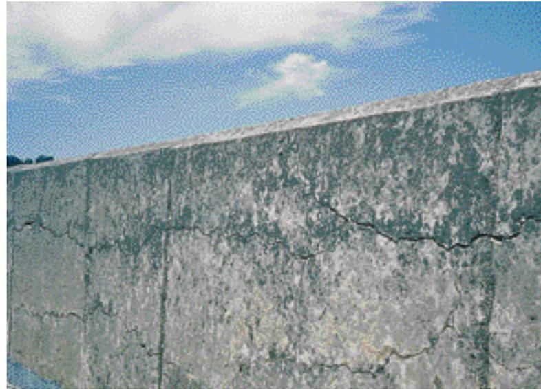
FIG. 3.8.1 Coronamiento del dique de Steenbras vecino a Ciudad del Cabo (Sudáfrica). La fisuración intensa visible en estas imágenes apareció como consecuencia de la hinchazón del hormigón causada por la reacción álcali – agregado.
