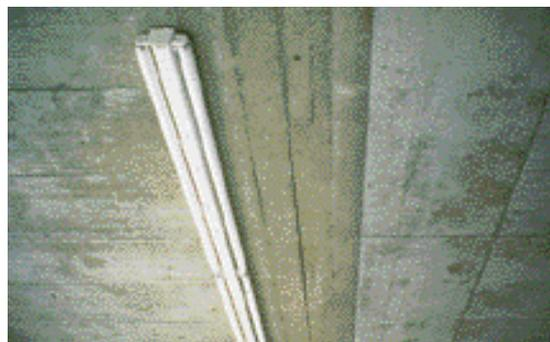
FIG. 2.6.5 Superficie inferior de un techo de estacionamiento: las diferencias cromáticas se deben a los diversos grados de absorción de los encofrados utilizados.
