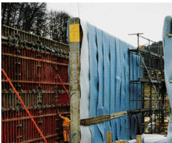
FIG. 2.8.3 Láminas aislantes que protegen las paredes apenas puesto en uso, ya sea de la deshidratación como de la pérdida muy rápida de calor.
