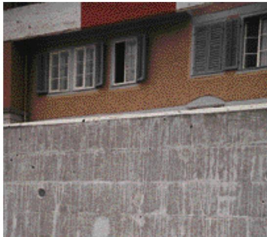
FIG. 3.4.1 Eflorescencia sobre un muro en hormigón.
