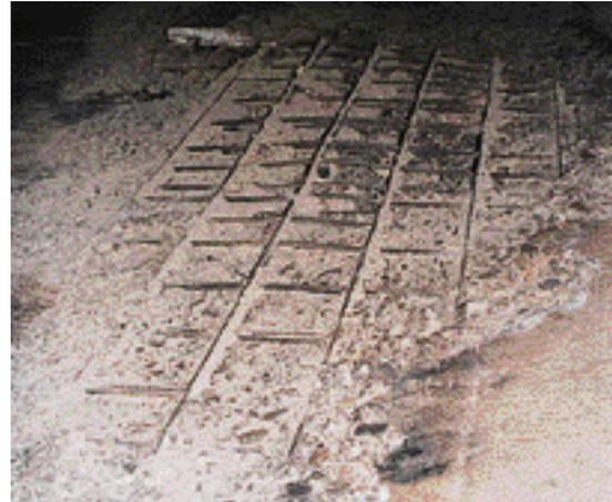
FIG. 3.9.1 Daños causados por el fuego: la armadura es puesta al desnudo como consecuencia de la disgregación del hormigón en superficie sin que la estructura esté comprometida.
