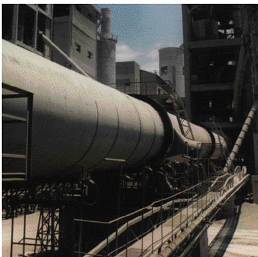
FIG. 1.1.3 Horno rotativo, corazón de una cementera.
