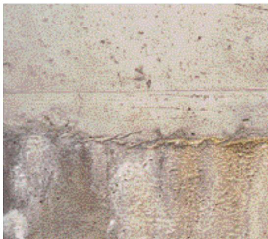
FIG. 3.4.2 Si el hormigón es poroso y el agua penetra en él constantemente, las eflorescencias pueden transformarse en verdaderas y propias condensaciones calcáreas.
