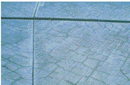
FIG. 3.2.2 Superficie de un estacionamiento: red de fisuras debidas a la contracción plástica.
