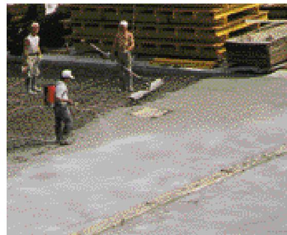
FIG. 2.5.3 Regado de un compuesto formador de membrana sobre una calle de hormigón.
