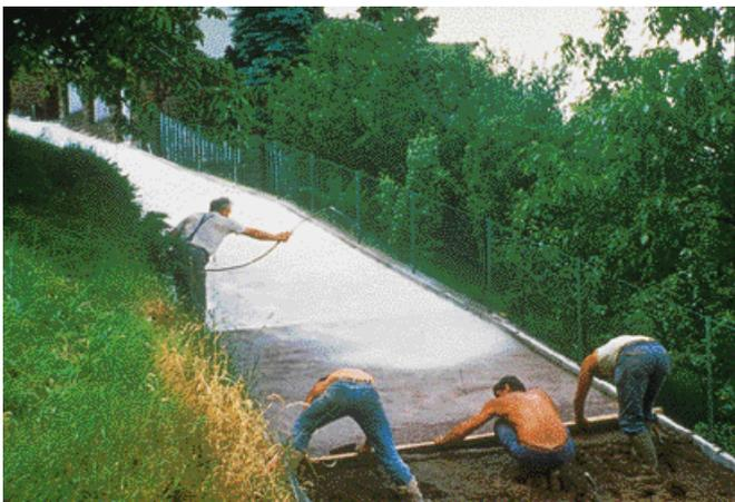
FIG. 2.7.4 Vaporización de un producto para formación de membrana de curado inmediatamente después de la terminación superficial.
