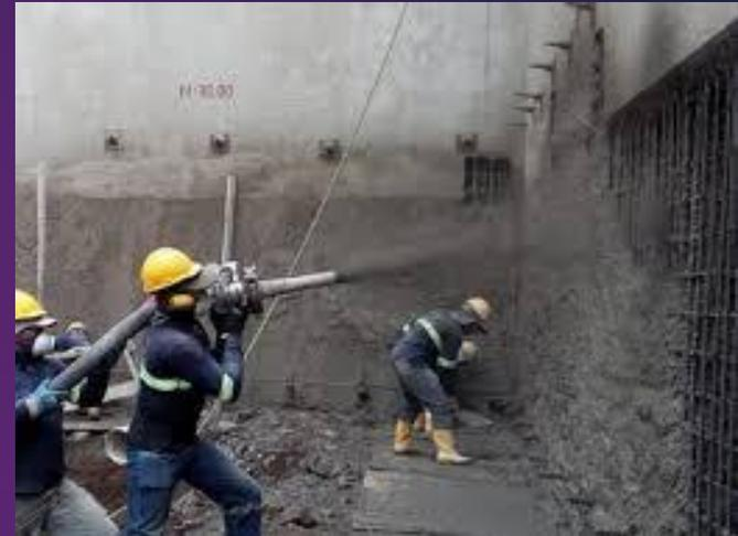
Hormigón proyectado o Gunitado o shotcrete
