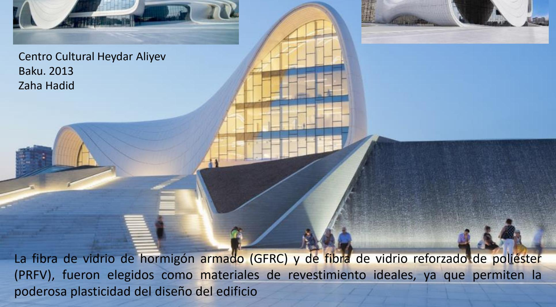
La fibra de vidrio de hormigón armado (GFRC) y de fibra de vidrio reforzado de poliéster (PRFV), fueron elegidos como materiales de revestimiento ideales, ya que permiten la poderosa plasticidad del diseño del edificio
