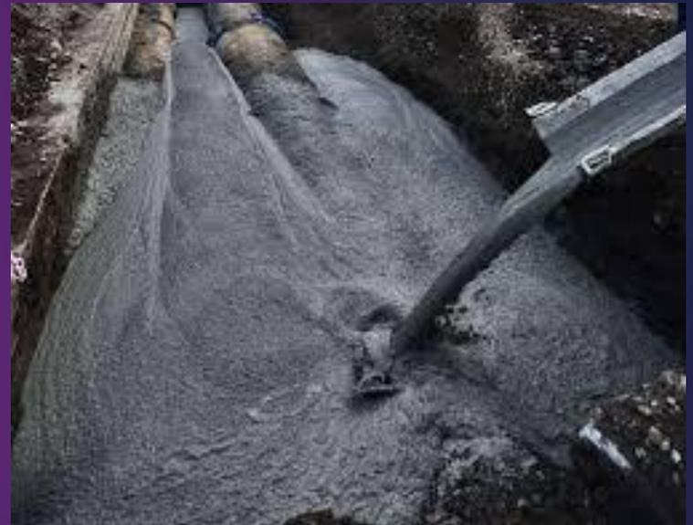
Hormigón de espuma/ Relleno de Densidad Controlada (RDC)
