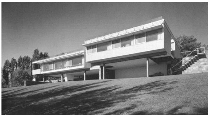
Fig. 174. Vista exterior de la Casa Starkey
