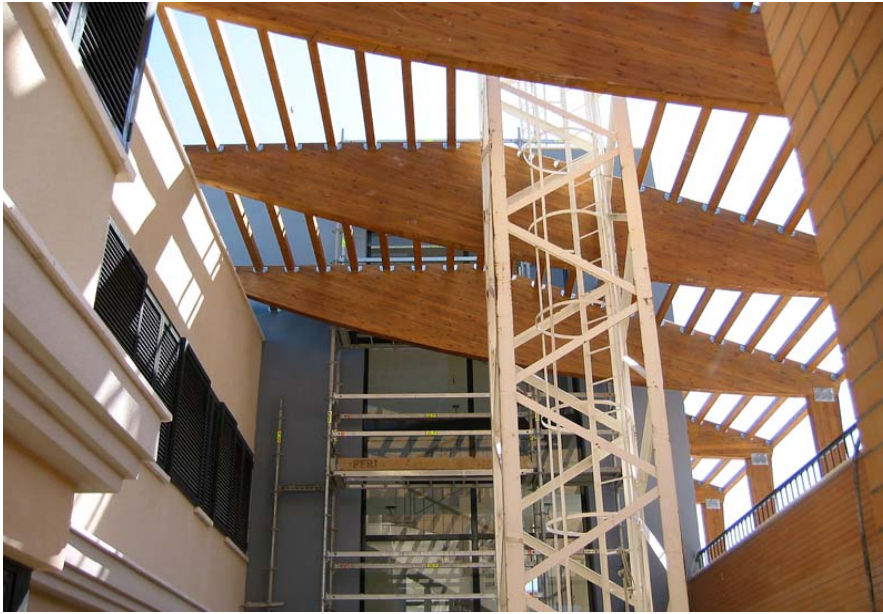
Fig. 197. Edificio público en Málaga, España. Vigas tipo “vientre de pez” biarticuladas. Luz libre: 10 metros
