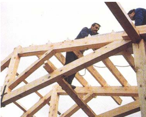
Fig. 18. Estructura de cubierta de madera aserrada
