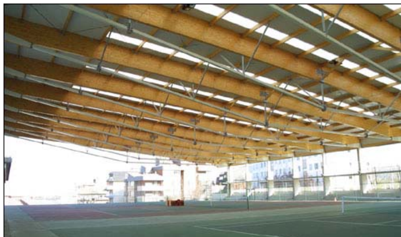
Canchas de tenis cerradas. Vigas atensoradas. Luz libre: 40 metros
