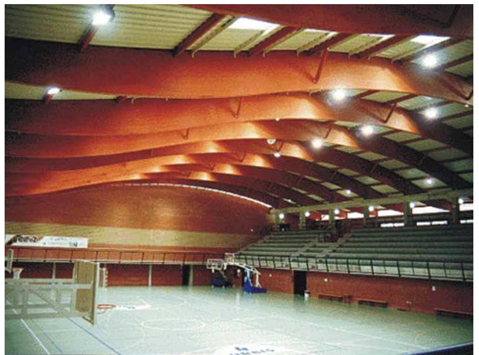
Fig. 192. Polideportivo en Molina de Segura, Murcia, España. Vigas curvas biarticuladas de sección variable. Luz libre: 38 metros
