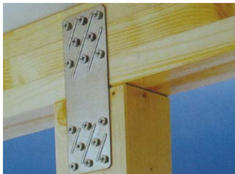
Fig. 64. Algunos tipos de conectores vistos metálicos para unir viga con pilar
