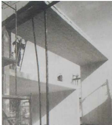
Fig. 46. Estudio en Schopfheim, Alemania: montaje e interior terminado. Las piezas en cajón con aislación construyen muros y entrepisos, las esquinas se definen con pilares de madera maciza; la estructura queda vista en el interior ofreciendo una superficie libre de juntas muy abstracta.
