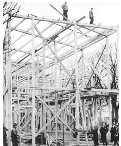
Fig. 17. Triangulación de vanos por medio de diagonales de madera. Construcción del pabellón de la U.R.S.S. en la Exposición Internacional de las Artes Decorativas en París (Melnikov, 1925)
