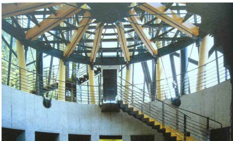
Ejemplo de sistema de vigas atensoradas: Worship Hall, Kawanishi, Hyogo, Japón (1998). Shin Takamatsu
