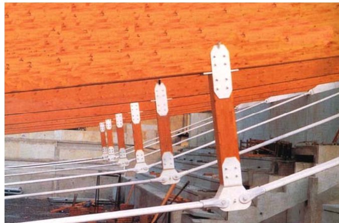
Viga de madera aserrada armada con sist. de atirantado Detan
