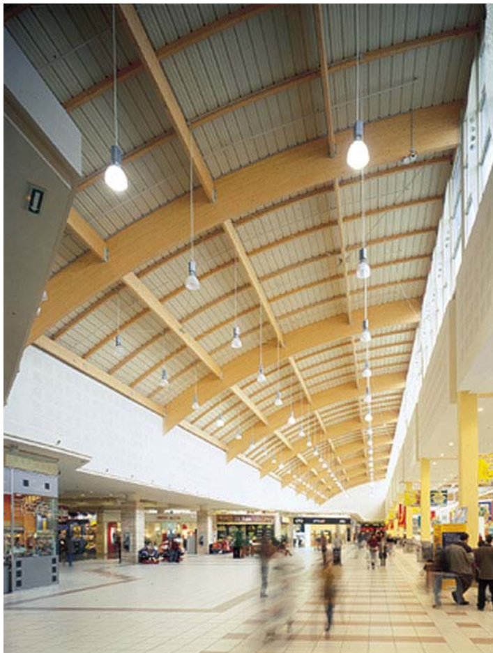
Fig. 196. Centro comercial en Álava, España. Arcos biarticulados. Luz: 15 metros
