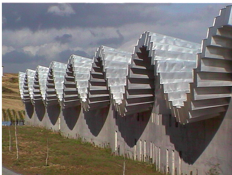
Fig. 182. Vista exterior del edificio. Fachada norte.
