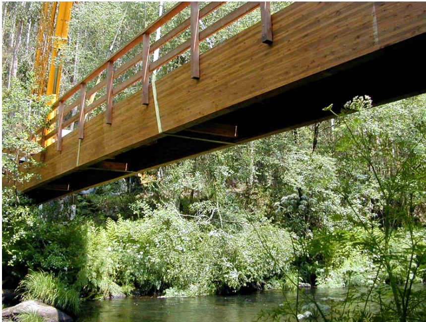
Fig. 200. Pasarela en La Coruña, España. Luz: 40 metros
