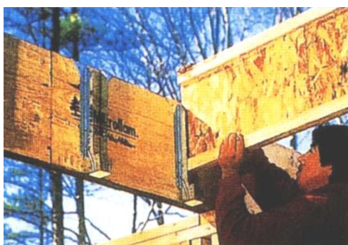
Entramado de vigas de madera microlaminada y perfiles doble T con alma de tablero OSB.
