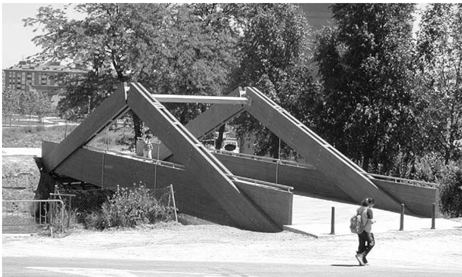
Fig. 201. Pasarela de Castilla, Valladolid, España. Luz: 26 metros
