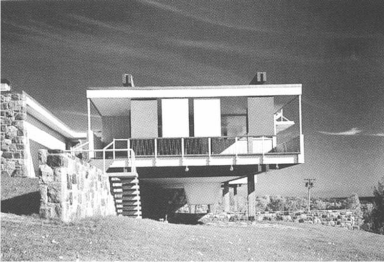
Fig. 176. Exterior de la Casa Starkey y esquema de la estructura de madera utilizada; a diferencia de la Casa Breuer I, en la Casa Starkey, son las vigas las que se duplican, dejando pasar los pilares entre ellas, también con la ventaja de que ambos elementos pueden ser continuos.
