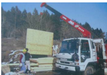
Fig. 173. Distintas imágenes del montaje en obra.
