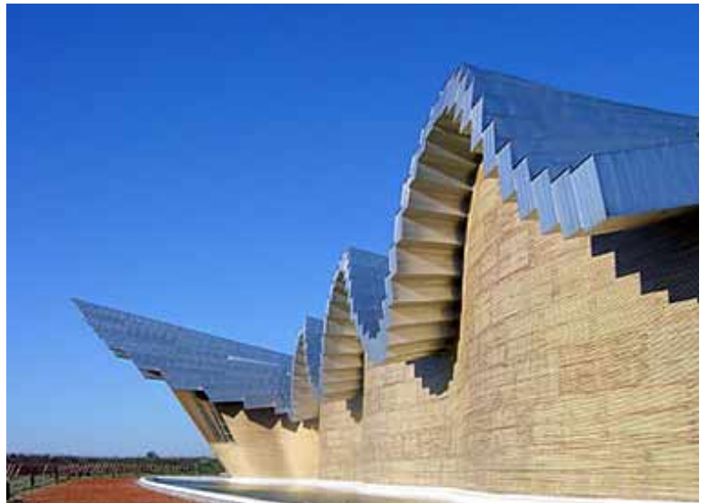
Fig. 180. Fachada sur revestida con lamas horizontales de madera de cedro. La estructura del techo está compuesta por una serie de vigas de madera laminada formando una superficie ondulada reglada, revestidas exteriormente con paneles de aluminio.
