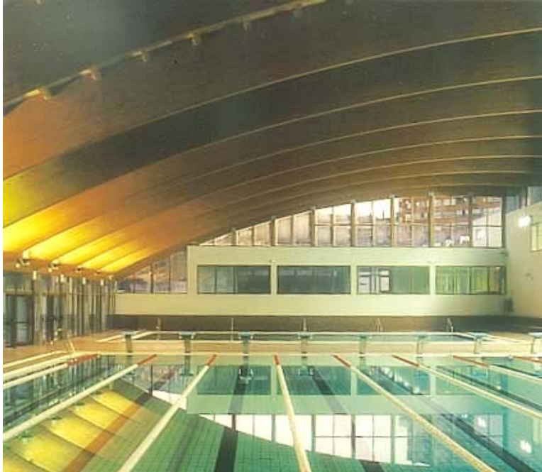
Fig. 191. Piscina olímpica techada en Capisco, Burgos, España. Arcos biarticulados. Luz libre: 20 metros.
