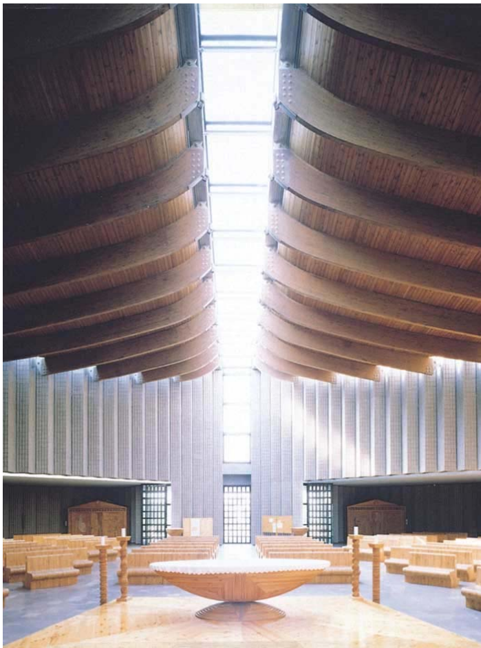
Fig. 198. Iglesia de Santa María del Redentor, Roma, Italia. Vigas curvas biarticuladas. Luz máxima: 28 metros
