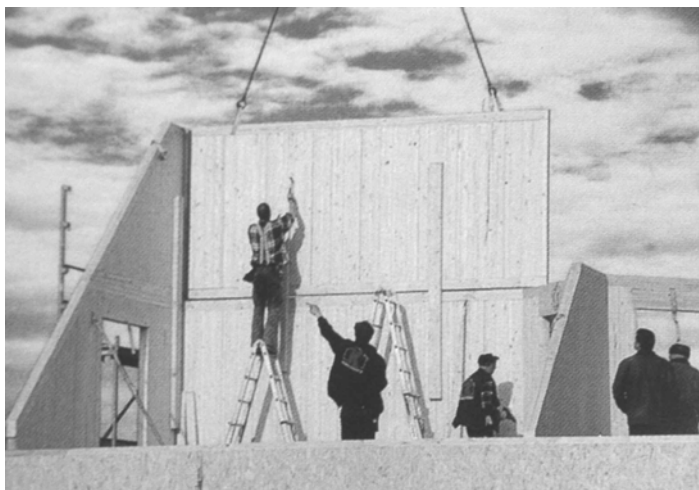
Fig. 48. Montaje del sistema en obra
