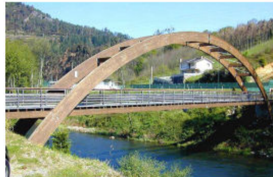
Fig. 24. Ejemplo de una pasarela en Lugo (España) de 25 metros de luz, y un puente en Pontenova (España) de 40 metros de luz, formado por un tablero suspendido de arcos triarticulados. Ambas estructuras están realizadas enteramente de madera laminada.
