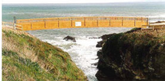
Fig. 24. Ejemplo de una pasarela en Lugo (España) de 25 metros de luz, y un puente en Pontenova (España) de 40 metros de luz, formado por un tablero suspendido de arcos triarticulados. Ambas estructuras están realizadas enteramente de madera laminada.
