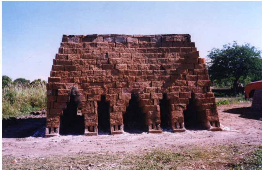
Horno de 50.000 ladrillos
