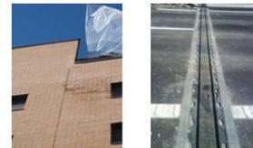
A la hora de diseñar estructuras es necesario tener en cuenta la variación de tamaño de sus componentes debido a la temperatura, por ello es necesario dejar **juntas de dilatación**.
